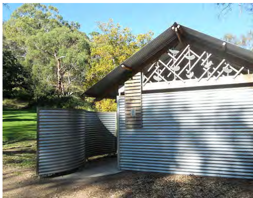
Die mure en dak van hierdie huis is van plate gegolfde staal gemaak.
