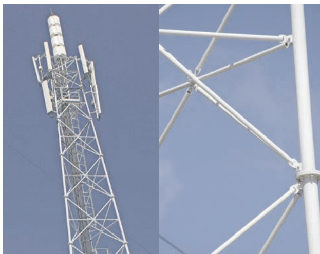
Figuur 3.20a Die staalpilare van hierdie selffontoring is swaarder as al die ander dele
