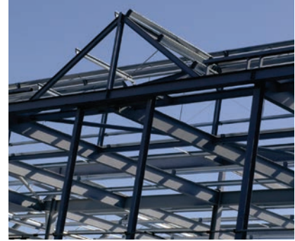
Figuur 3.24c Staalbalke in 'n staalraamgebou
