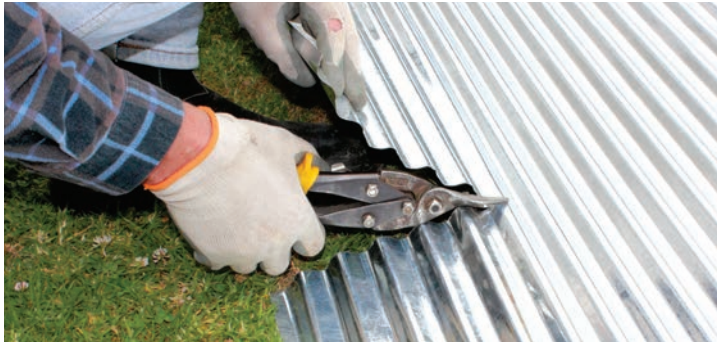
Figuur 3.25 'n Blikskêr knip die plaatmetaal met 'n skuifaksie.
