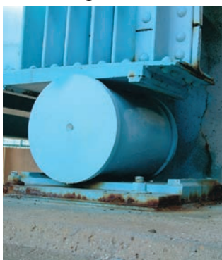
Figuur 5.9d Daar is 'n laer tussen elkeen van hierdie steunkolomme en die brugstruktuur bo.
