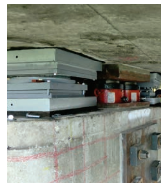
Figuur 5.9d Daar is 'n laer tussen elkeen van hierdie steunkolomme en die brugstruktuur bo.
