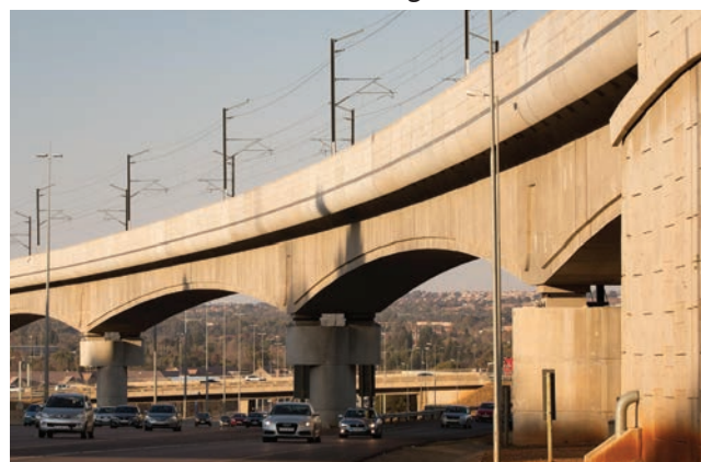
Figuur 5.9d Daar is 'n laer tussen elkeen van hierdie steunkolomme en die brugstruktuur bo.
