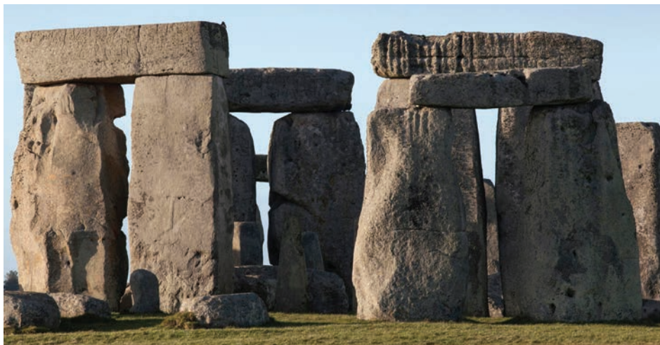
Figuur 5.8 Antieke balke was gewoonlik eenvoudig ondersteun.
