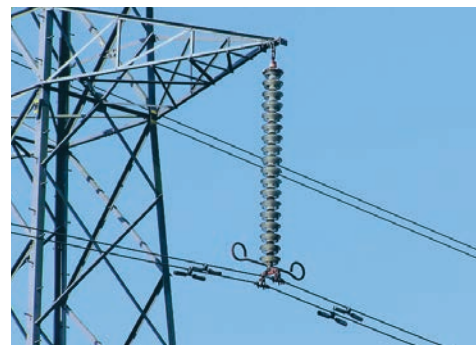
Figuur 11.20 Kragdrade hang aan 'n string glasisolators.
