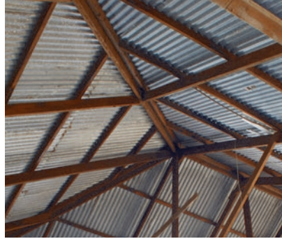
Figuur 3.24b Houtkaplatte wat 'n sinkdak stut
