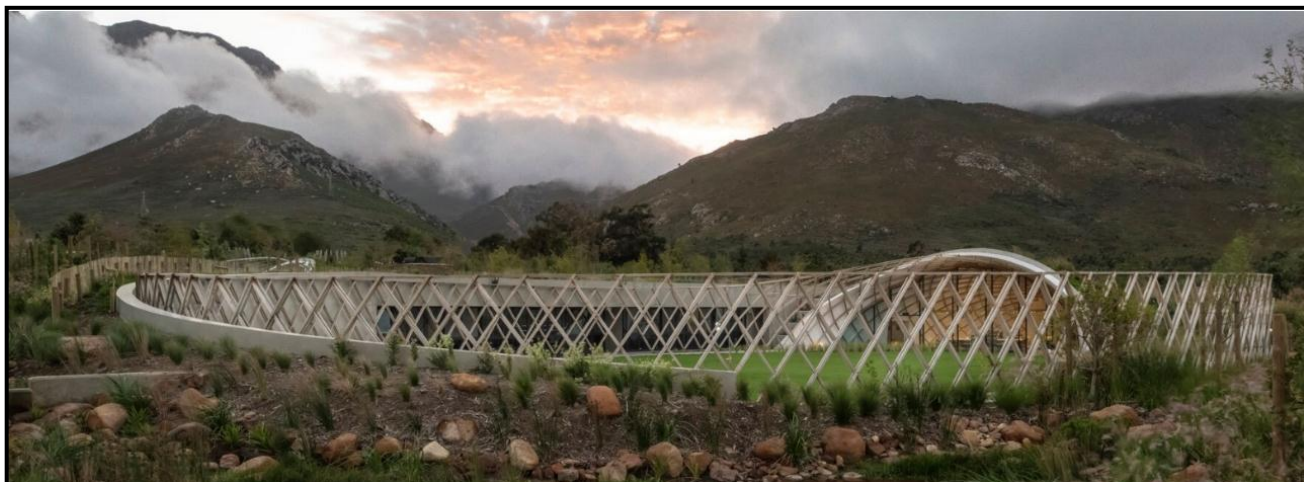
FIGUUR 8a: Steyn Studio, Garden Café (Tuinkafee) , gekromde eikehoutbalke, glas en beton, 2020.
